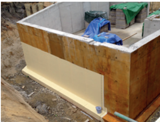
Auf der Sauberschicht verlegtes FBV-System inklusive Rohrdurchführungen
